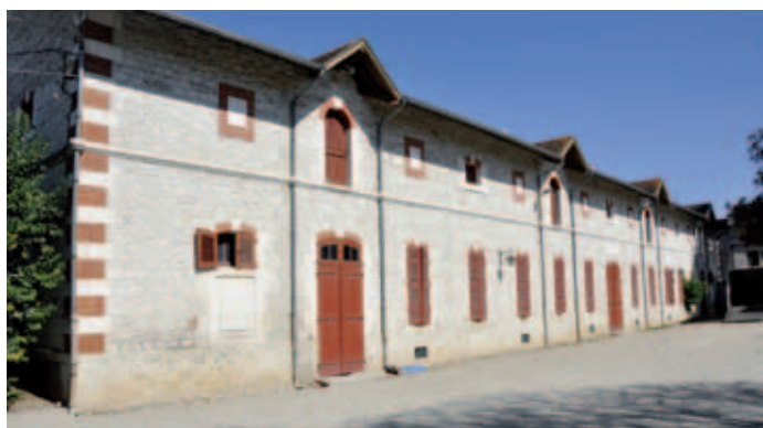
Lutter contre la désertification médicale avec une nouvelle maison de santé aux Haras
